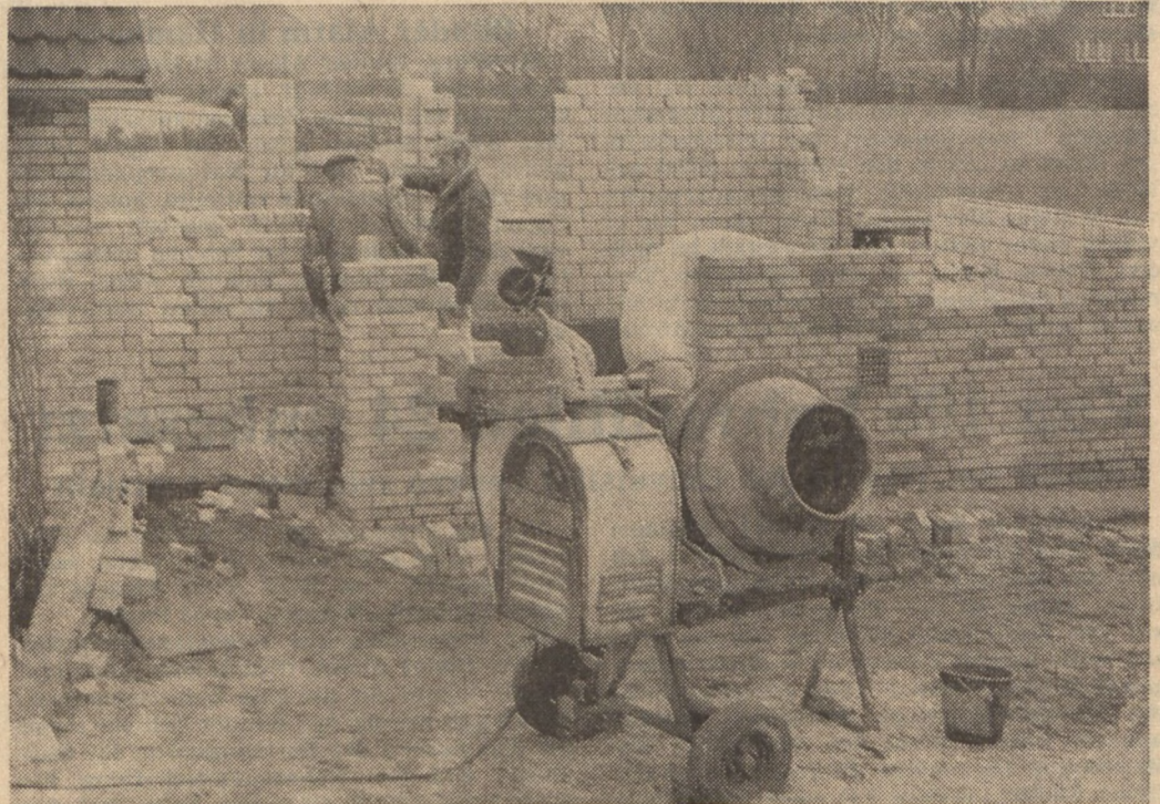
Der kleine Anbau mit der Erwärmungsanlage für das Quickborner Freibad soll mit der Installation rund 55 000 Mark kosten. Rechts im Bild ist der 10 000-Liter-Öltank zu erkennen, der kürzlich eingebaut wurde.
